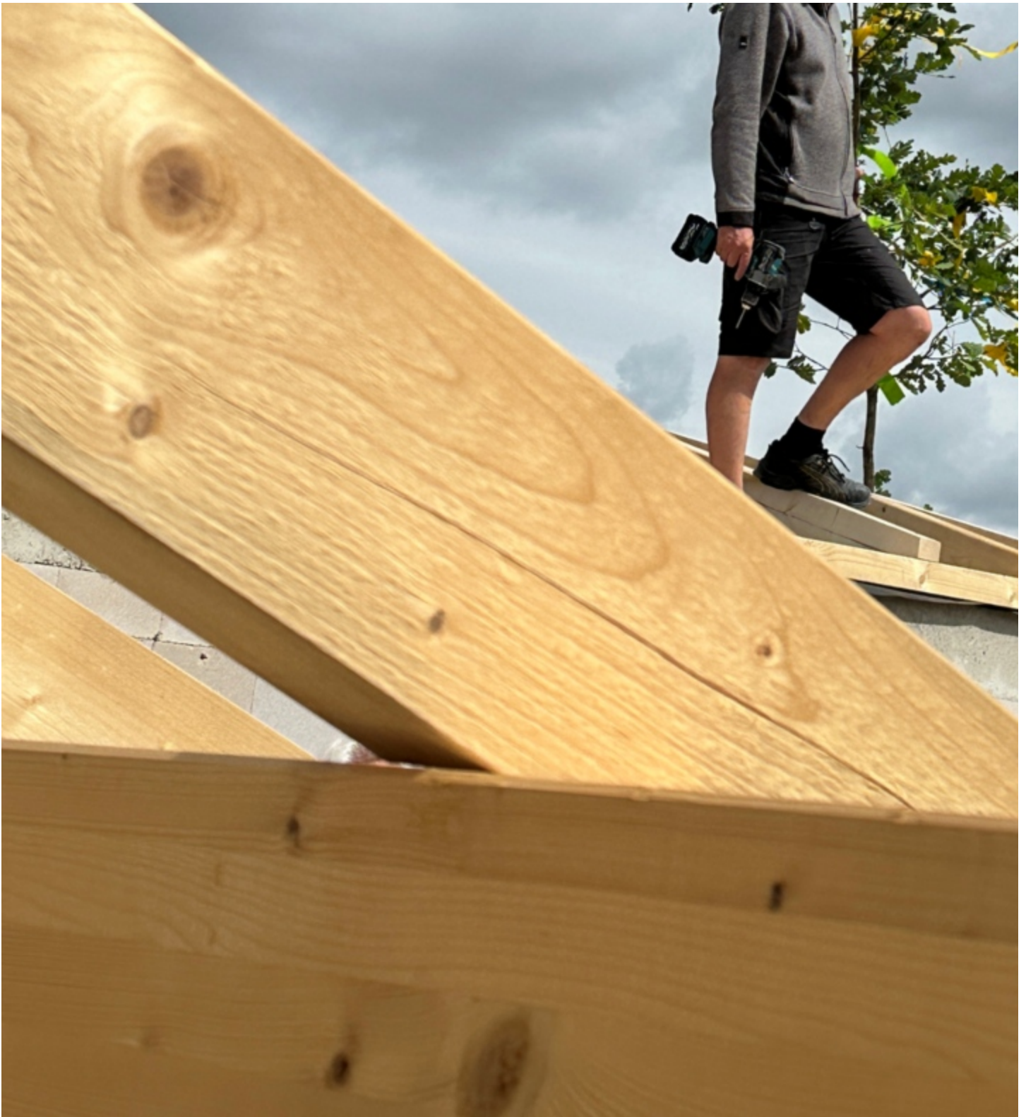
Auf dem Bild zu sehen: Zimmermann-Meister Andreas Schulte mit dem traditionellen Richtbaum - davor der fertige Dachstuhl des Caritas Haus Don Bosco.
